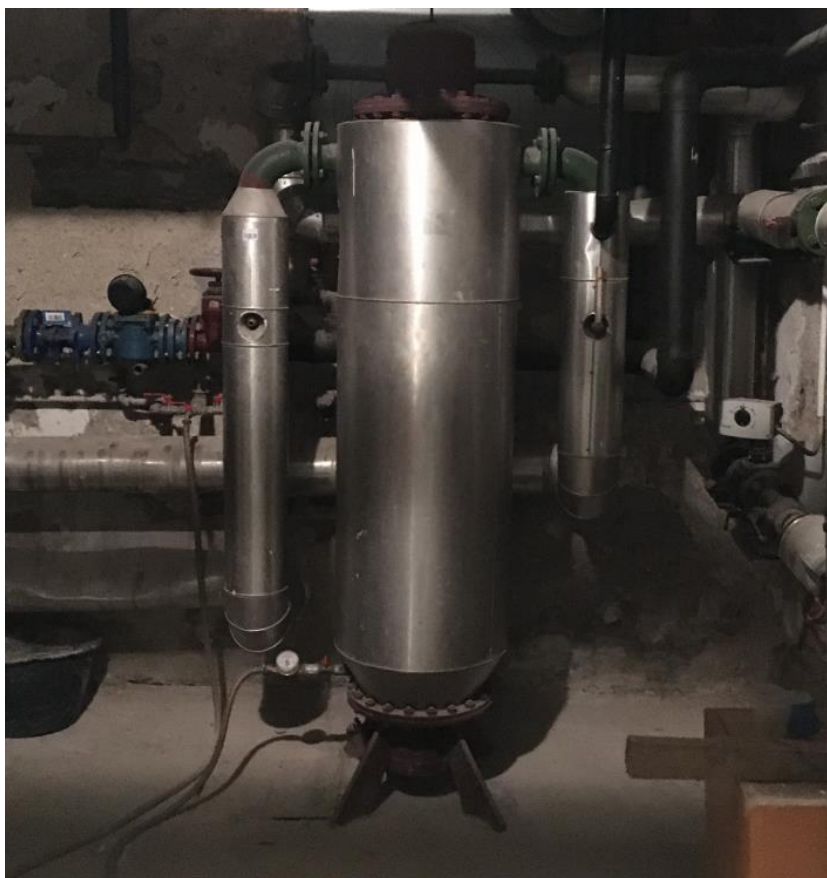
Slika 4.1: Zastarel spiralni toplotni izmenjevalec
