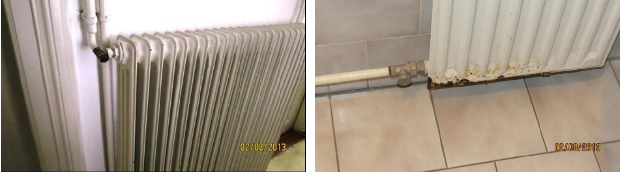
Slika 4.5: Radiator z navadnim ventilom in zapiralom (levo) in star in popolnoma dotrajan radiator (desno)
