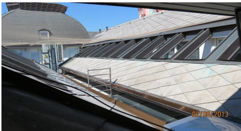
Slika 5.3: Azbestna kritina nad toplotno neizoliranim stropom
