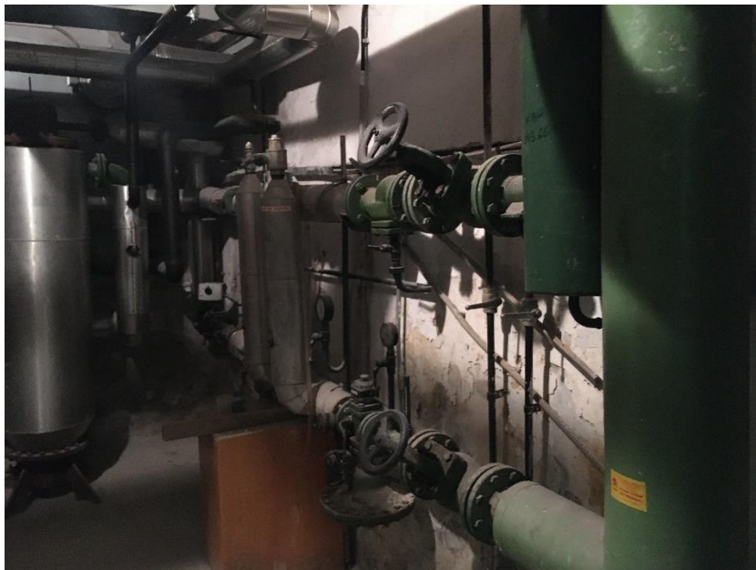
Slika 4.3: Zastarela regulacija in dotrajani ventili v toplotni postaji
