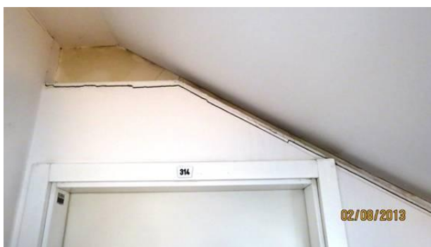
Slika 5.4: Strop proti neizoliranemu podstrešju
