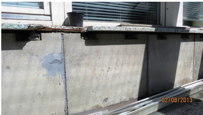
Slika 5.2: Dvoriščna (notranja) fasada objekta
