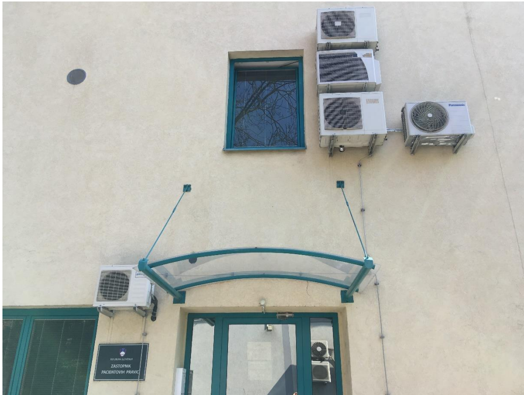
Slika 4.5: Zunanje enote split-klimatskih naprav
