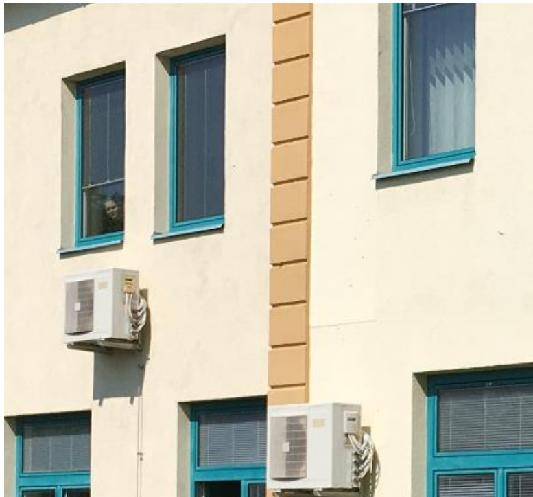
Slika 5.1. Nova PVC okna ter fasada objekta
