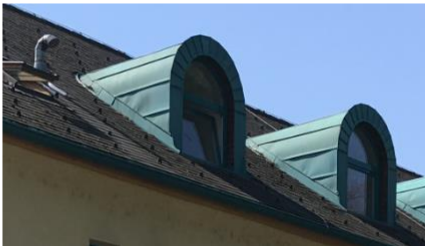
Slika 5.2: Frčada in streha na objektu
