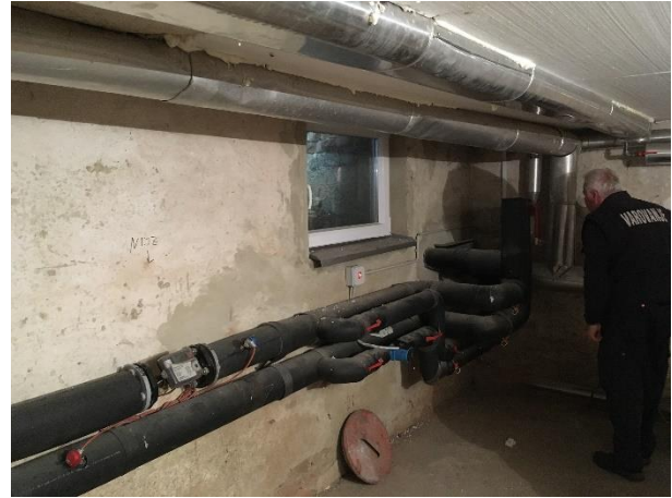
Slika 4.2: Del razdelilnika (levo) in razvoda (desno) za ogrevno vodo
